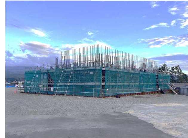
P1橋脚 施工状況
